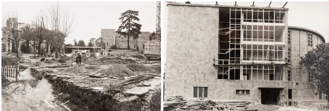
Obres del nou edifici
