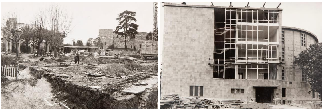
Obras del nuevo edificio
